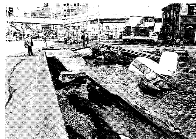
震災直後の港湾付近
