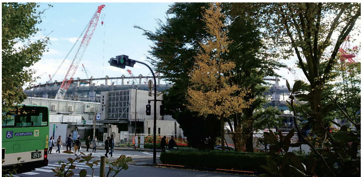
建設中の2020年東京オリンピックのメイン会場「新国立競技場」
